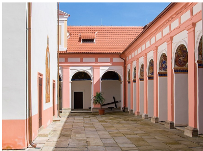
poutní areál Římov po rekonstrukci
